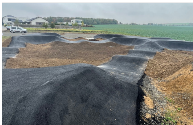
Pumptrack je už prakticky hotový. zbývají ještě terénní úpravy a výsadba stromů.
